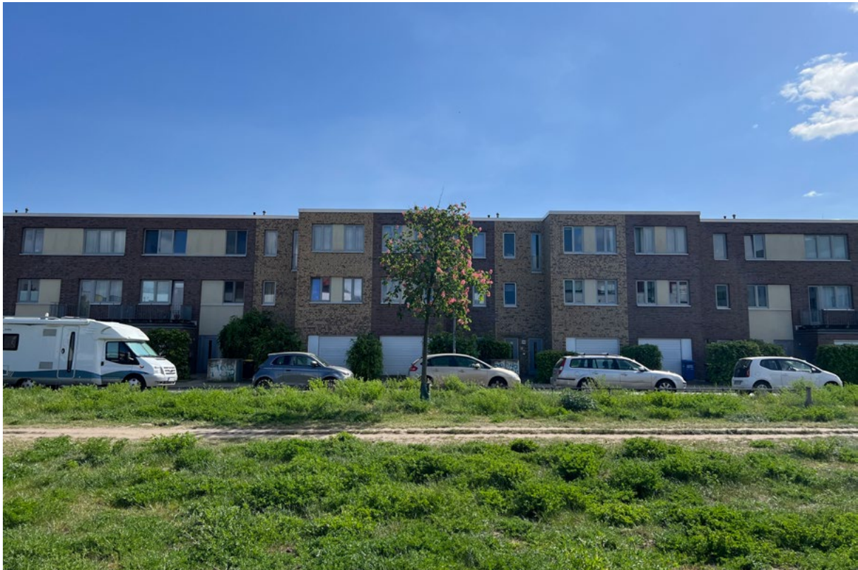
Reihenhäuser in urbaner Dichte gebaut, als kompakte Form des Einfamilienhauses. Foto: Josephine Çimentepe/ vhw e. V.
