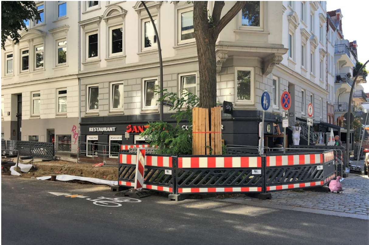
Baum in Baustelle. Quelle: Christine Neubert.
